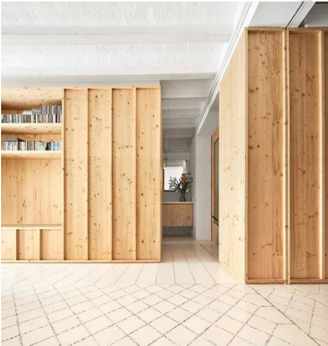
Trespol de rajoles hidràuliques (Imatge: TED'A Arquitectes)
