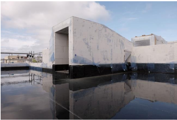
Coberta impermeabilitzada amb EPDM (imatge: IBAVI)
